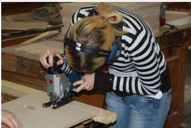
Dann wird mit der Stichsäge bis zu den vorgebohrten Löchern und noch quer gesägt.
