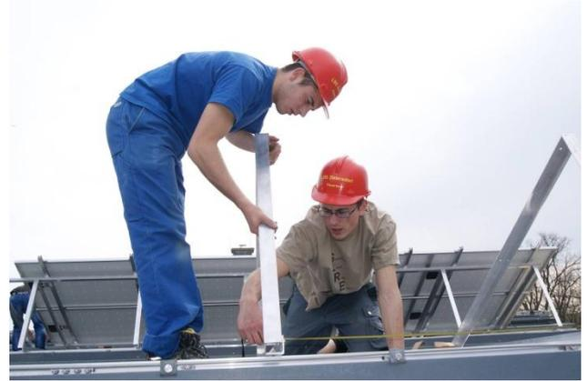
Die Montage der Aufständerung bzw. die Befestigung der Module, die Verbindungstechnik der einzelnen PV-Module untereinander und die Leitungsführung zu den Wechselrichtern wurden hier erlernt. Erst die restliche elektrische Verdrahtung erfolgte durch einen konzessionierten Elektrikerbetrieb.
